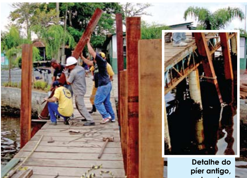
Início dos trabalhos no píer, com a colocação dos pontales.
