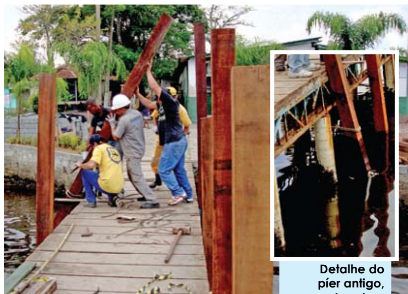
Início dos trabalhos no pier, com a colocação dos pontaletes.
